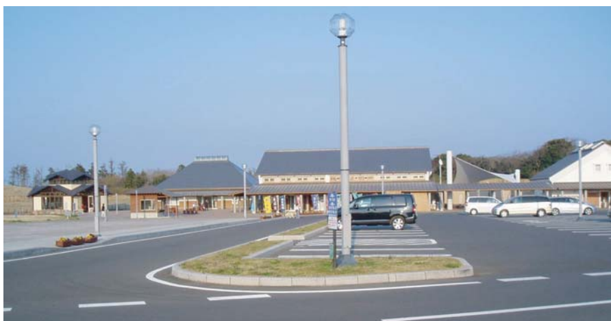
・センターゾーンの主要建築施設（左から花の四阿、管理棟、休憩棟、トイレ） 国道沿いに整備され、地元の野菜、魚貝類などの物産の販売も行われている。
