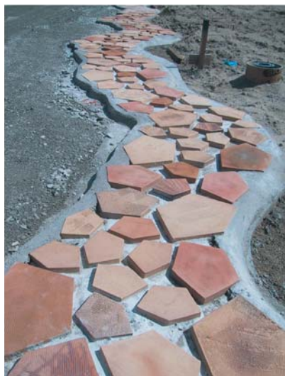
さまざまな陶芸家により少しずつ 焼かれた陶板を使った舗装の縁取り。
