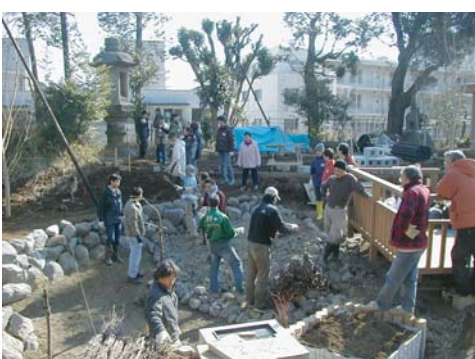
護岸をつくる
